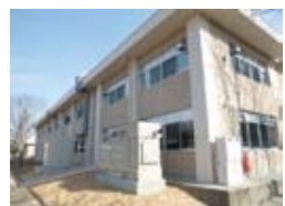
自家発電装置
